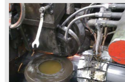
Surveillance de la température des rebords de conduits peu avant le soudage
