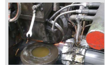
Supervisión de la temperatura de las coronas de tubería antes del soldado
