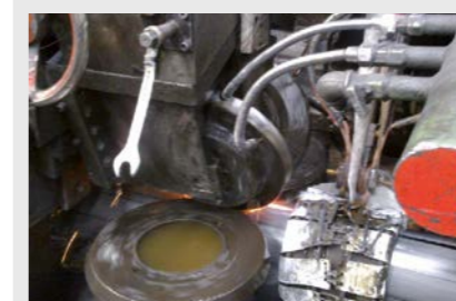
Temperaturüberwachung der Rohrränder kurz vor dem Verschweißprozess
